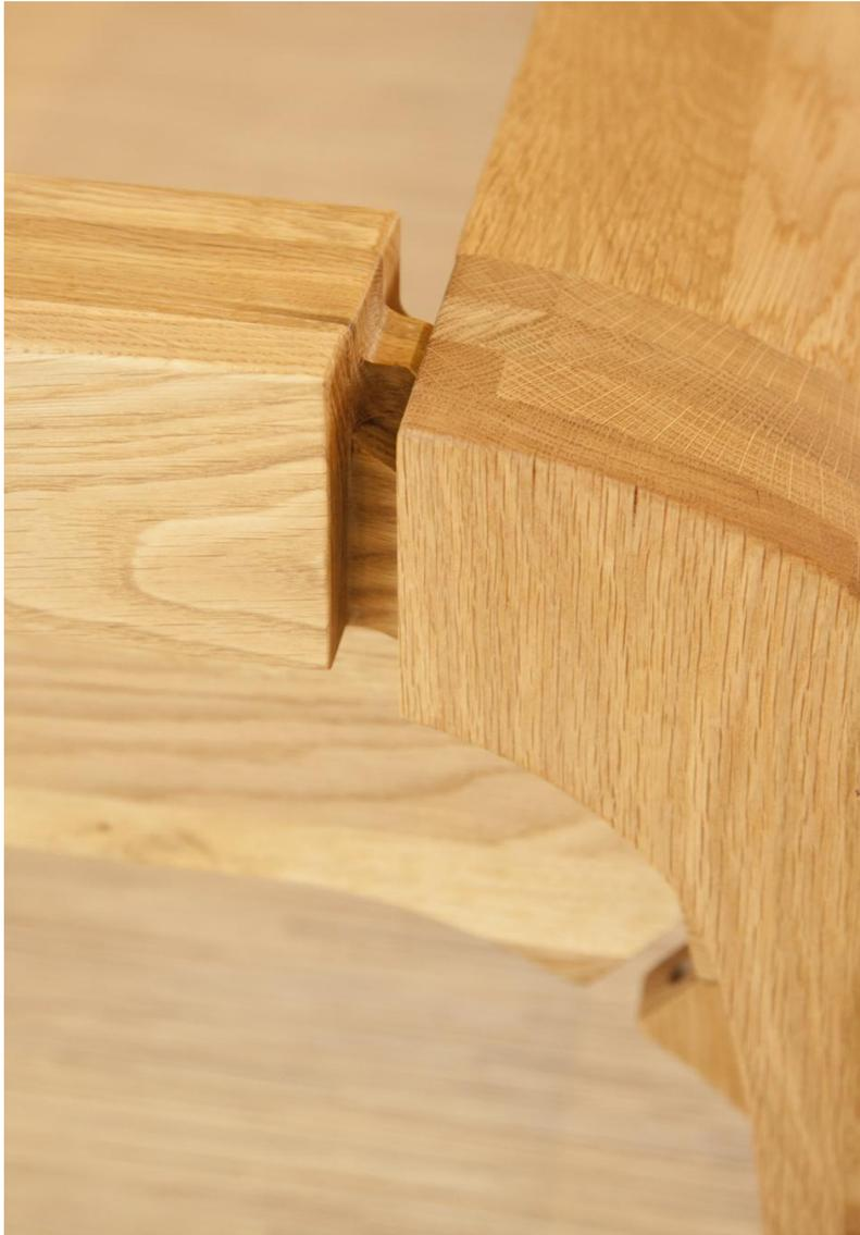
**Abb. 3) Soweit wie möglich einstecken, erst wenn alle vier Seiten miteinander verbunden sind, wird mit dem Hammer nachgeklopft (siehe Punkt 8!).**
