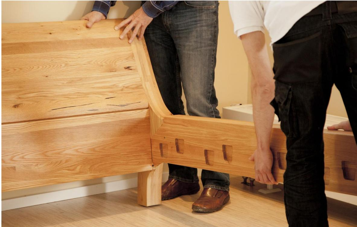
**Abb. 1)** Seitenteil in Kopfteil einfädeln.
